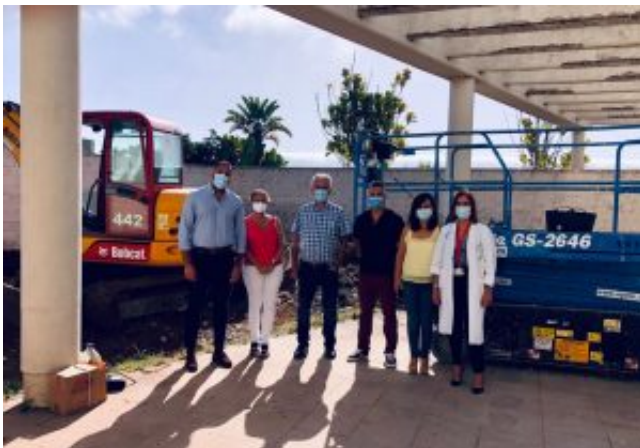
Visita a las obras de la 'Sala COVID-19'
